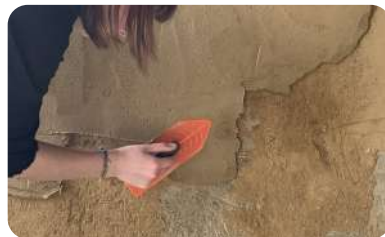
Élève de l'École Être 32 en atelier enduits terre
