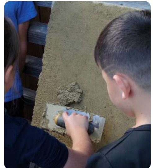
Élèves s'initiant à l'application d'enduits terre
