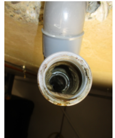
A gauche : canalisation après démontage, entretien des urinoirs sans eau pendant 10 ans
