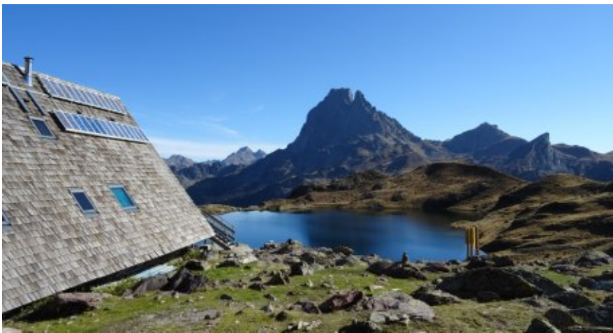
Refuge d'Ayous en vallée d'Ossau (64), Parc national des pyrénées
