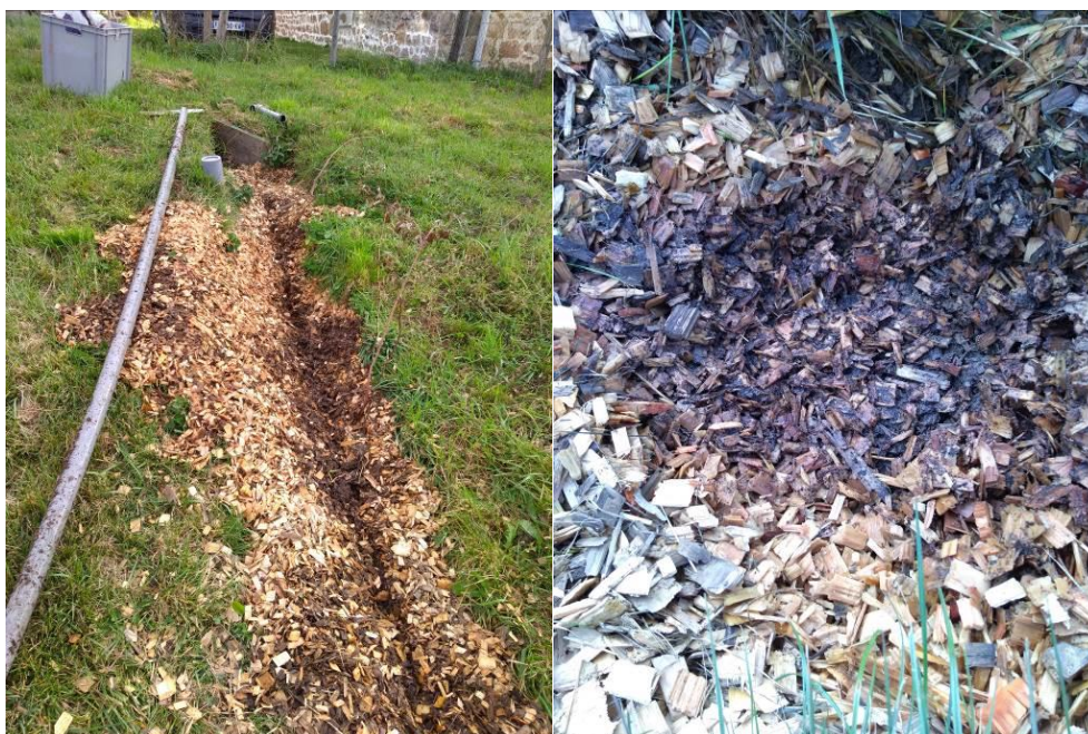
Photographies 16 : Site 5, aspect du filtre.
