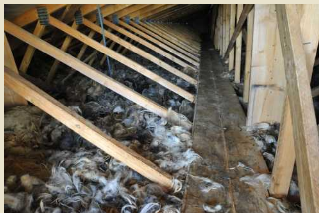
laine de mouton dans les combles
