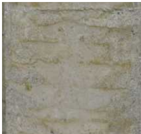
mur en pisé
