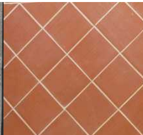
sol en mortier de chaux et de terre
