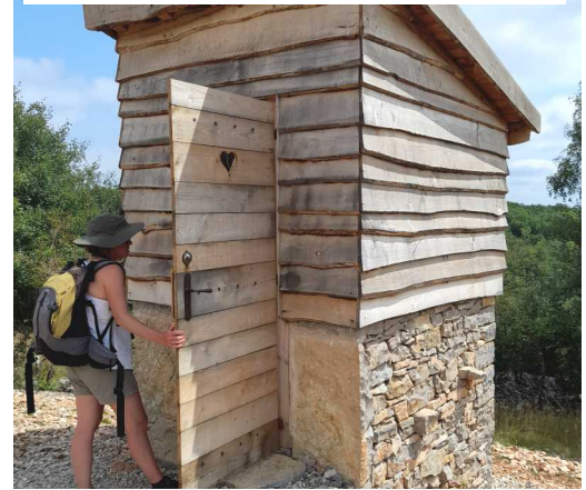
Ces toilettes sont construites en pierres sèches et châtaignier, sur le site du Super Cayrou classé au patrimoine mondial de l'UNESCO
