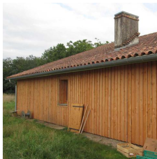
Isolation des murs par l'extérieur avec 14 cm de laine de bois
