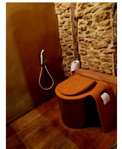
Pose de toilettes sèches reliées à un composteur
