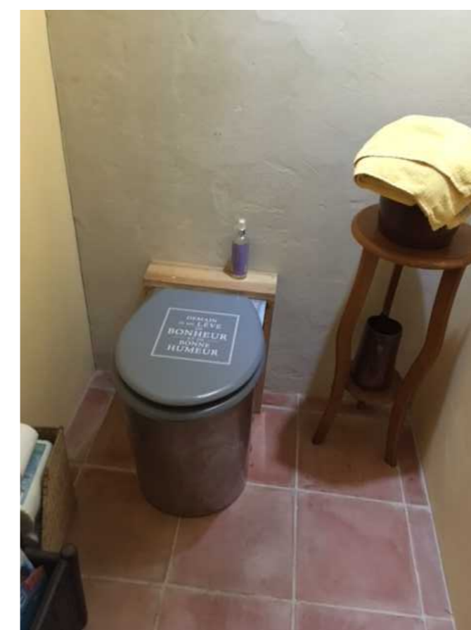
Pose de toilettes sèches sans sciure et reliées à un composteur maçonné
