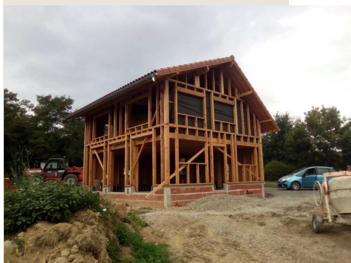
Pose d'une charpente bois spécifique à l'isolation paille (35 cm d'épaisseur dans les murs)
