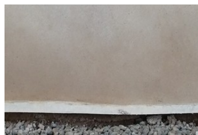
Photo de l'enduit sur la rupture en zinc
