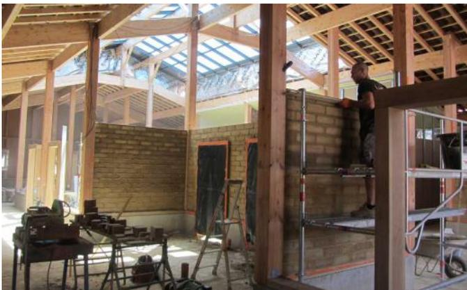
Remplissage de BTC entre les éléments de structure bois pour les cloisonnements intérieurs.
