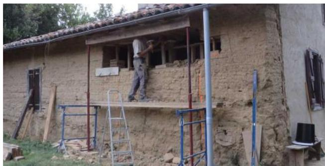
Ouverture d'un mur en pisé : loin d'un angle et emprise prévue pour le linteau (encoche à droite).
