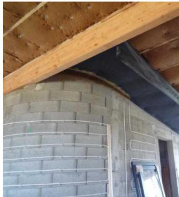
Fixation des tuyaux par clips sur le noyau en parpaing
