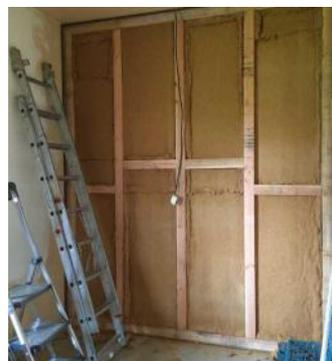
Cloison avec l'ossature bois et l'isolant
