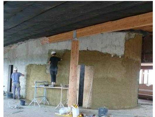
Barbotine sur le mur et les tuyaux. Application d'une seconde couche.
