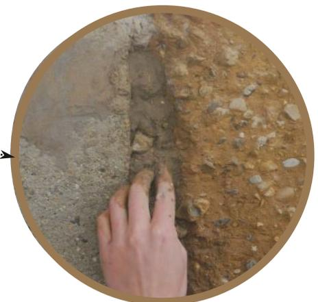
*Fissure de surface liée à un ruissellement d'eau : rebouchage avec de la terre tassée à la main*
