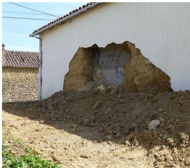
*Effondrement d'un bout de mur enfermé entre un enduit ciment et des blocs de parpaing*
