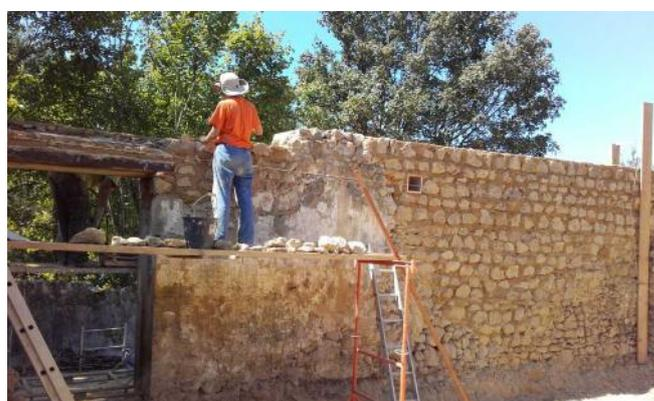
Vue sur un mur en construction : les rangées sont bien visibles
