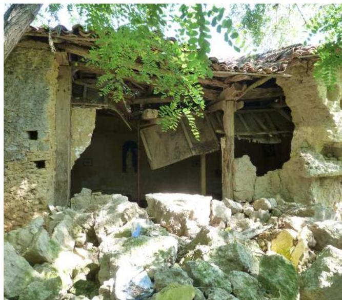
*Effondrement d'un mur à cause d'une toiture abîmée (poussée de la charpente et infiltration d'eau)*
