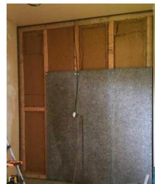
L'ossature en partie couverte par la fibralith
