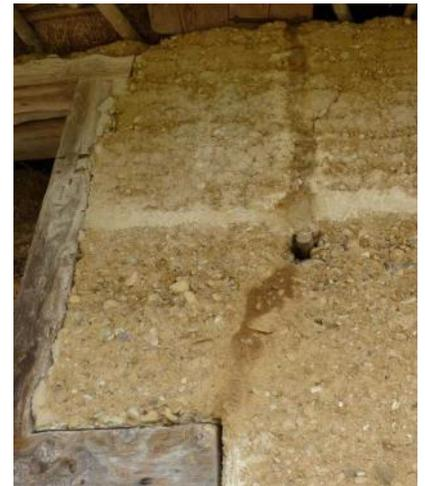
*Fissure verticale rebouchée liée à un désordre structurel (mur en terre massive)*
