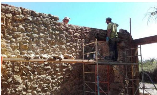
Les deux personnes en train de maçonner : le cordeau permet de suivre l'aplomb et la linéarité du mur
