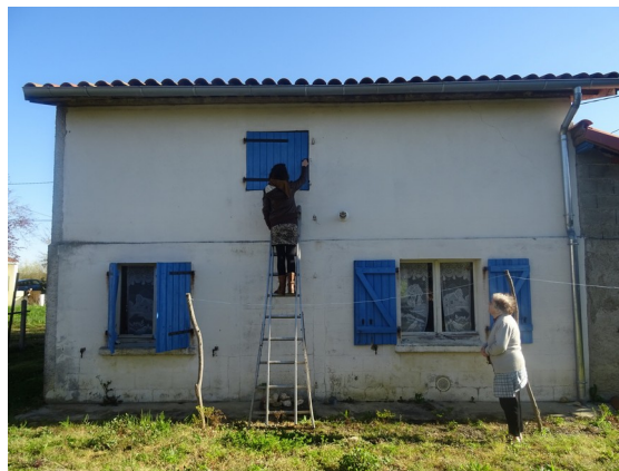
Inspection des combles
