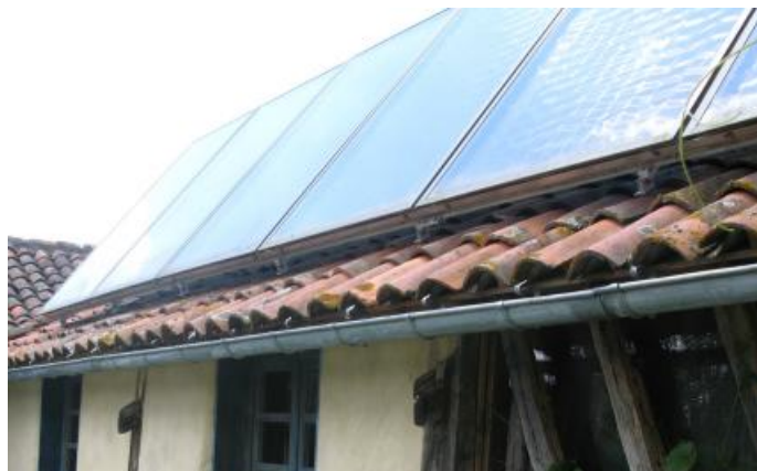
Les 6 panneaux solaires sont posés au sud.
