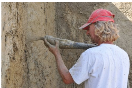
Projection de l'enduit terre
