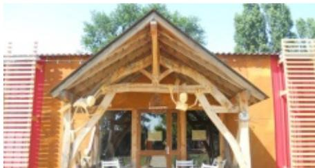
Le auvent du théâtre Spirale est façonné à partir d'une **charpente en bois tordu** qui respecte la forme des arbres et des branches et donc le sens de la fibre du bois et en augmente sa résistance mécanique.
