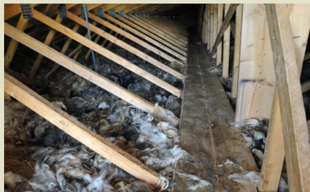
laine de mouton dans les combles
