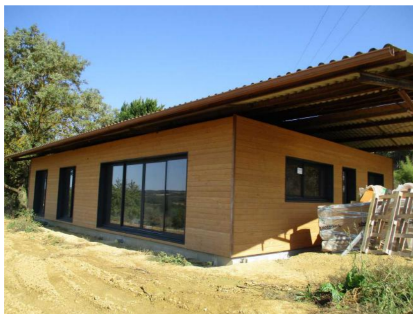
Pose d'un bardage horizontal sur des murs isolés avec 14 cm de laine de bois
