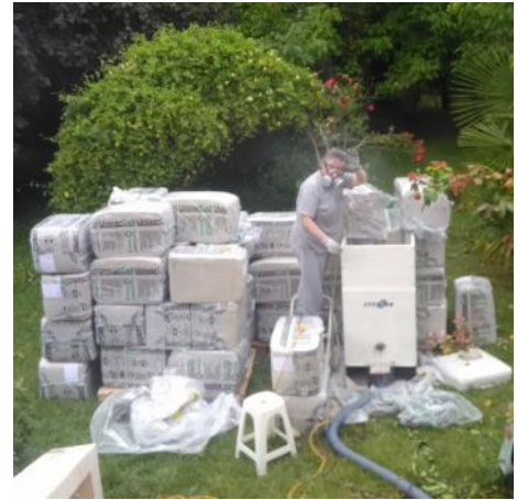
Emploi de matériaux biosourcés : isolation des combles en ouate de cellulose
