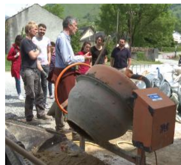
Chantier « pilote », en Auto-Réhabilitation Accompagnée
