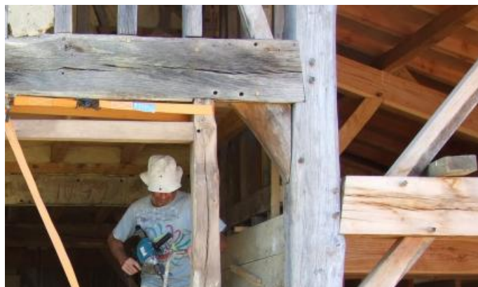
Le charpentier perce le trou de la cheville qui bloque l'assemblage en tenon-mortaise.
