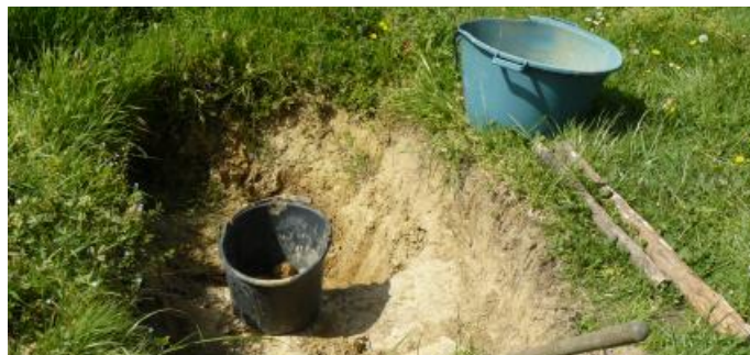
Extraction de la terre.
