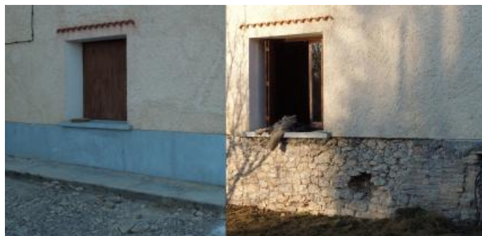
La façade avant et pendant les travaux.
