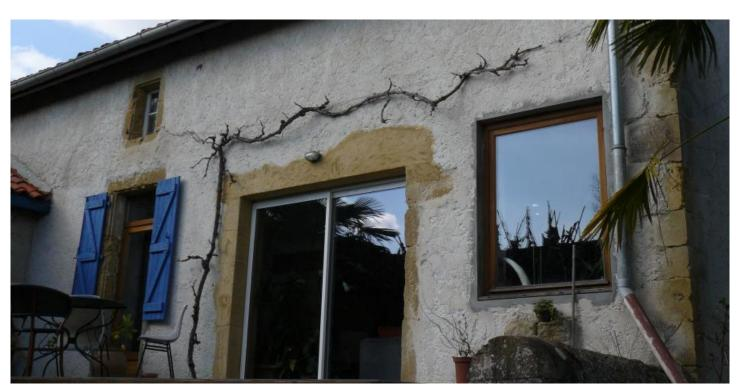
Façade sud après travaux. La surface du vitrage est augmentée et l'accès à la terrasse extérieure facilité par l'installation de la porte fenêtre (à gauche) et la baie vitrée (au centre).
