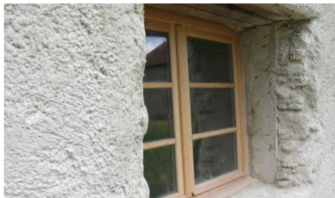
Enduit extérieur, finition enduit chaux aérienne-sable.
