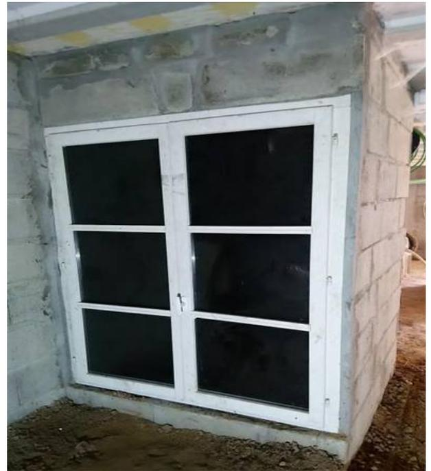
Composteur maçonné réalisé en parpaing, dans un sous-sol, avec une menuiserie étanche double vantaux
