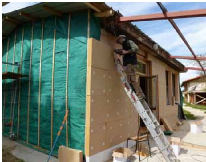
Isolation par l'extérieur en fibre de bois Centre de loisirs de Pierre et Terre
