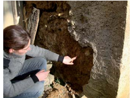
Salpêtre sur les murs
