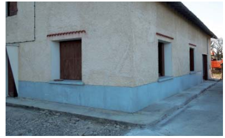
Enduits et trottoir en ciment
