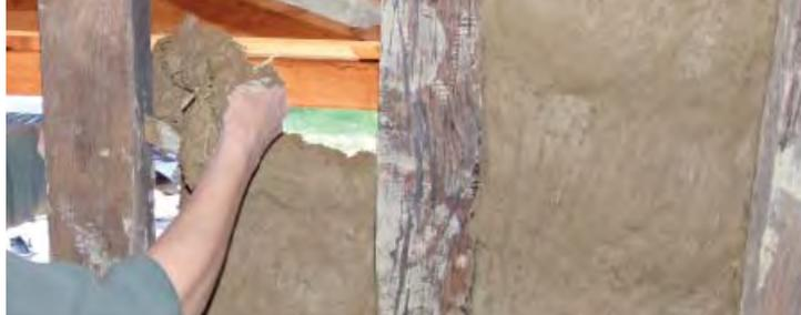
Il arrive que le remplissage d'un mur à colombage soit abîmé voire absent. Des solutions techniques différentes sont à mettre en œuvre selon l'emplacement du mur et de son rôle dans le bâtiment.
