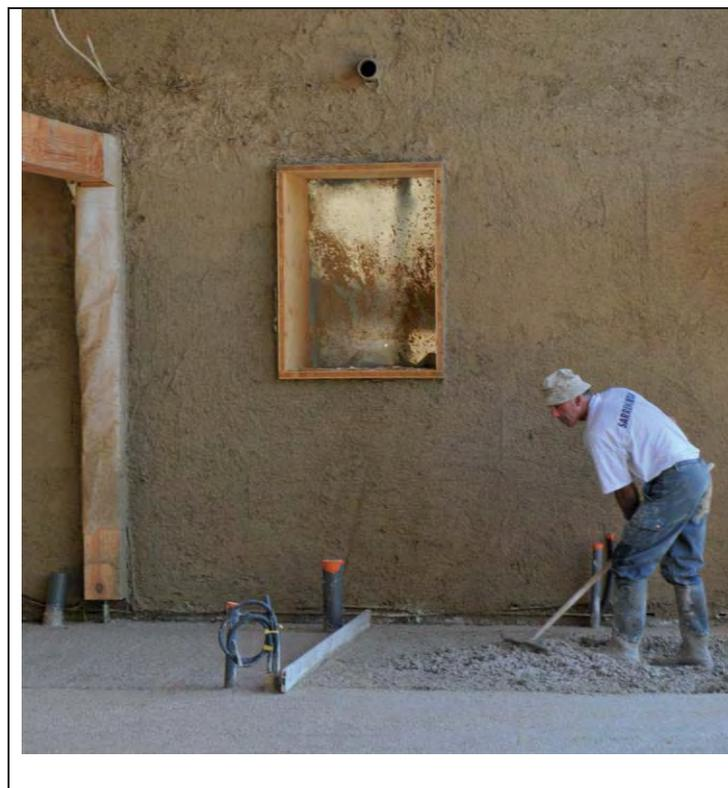
Pose de la chape isolante chaux-chanvre intérieure (épaisseur 18 cm) par un maçon conventionnel. Elle sera recouverte d'une chape de pose et de carreaux de terre cuite pour ajouter de l'inertie dans le bâtiment. Cadre bois flottant prêt à accueillir les menuiseries en bois (mélèze).
