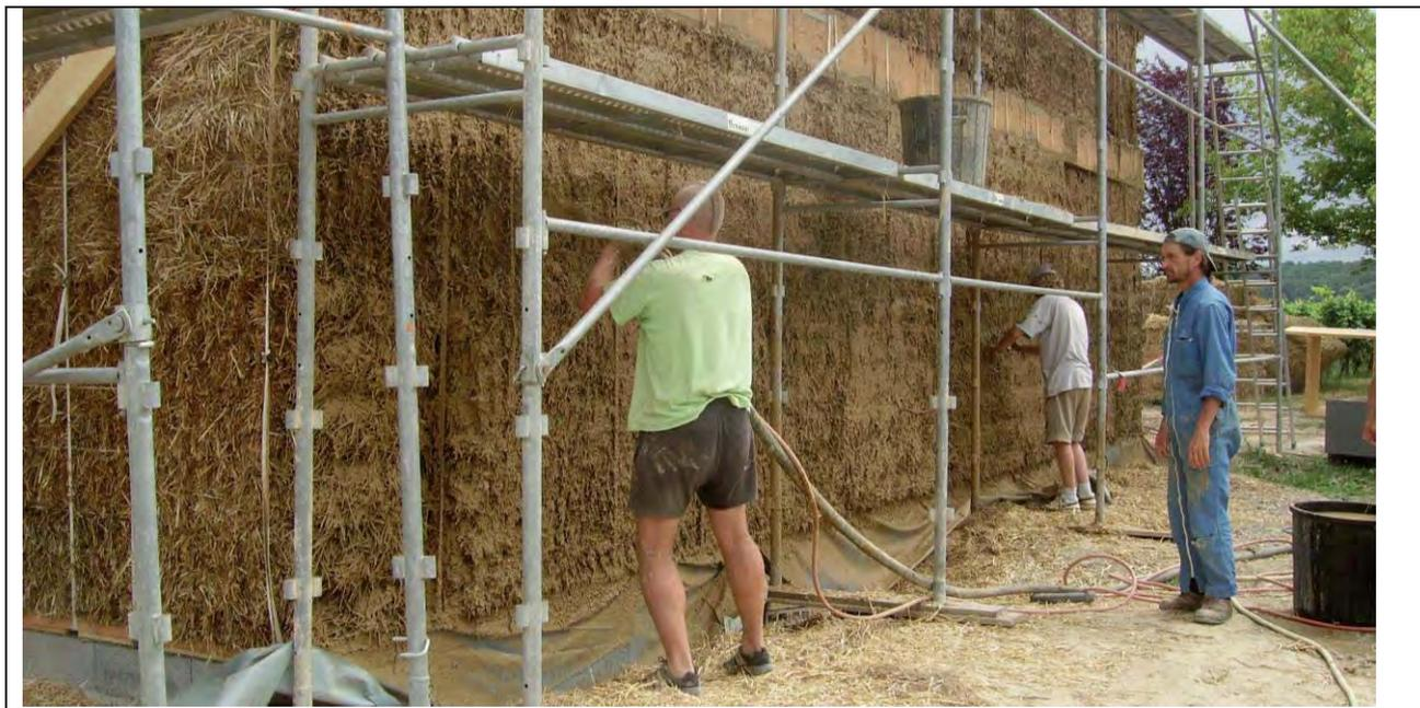
Pose du gobetis extérieur (projeté à la machine) sur les grosses bottes de paille. Préparation pour recevoir la couche de corps de l'enduit terre puis l'enduit de finition à la chaux aérienne en pâte.
