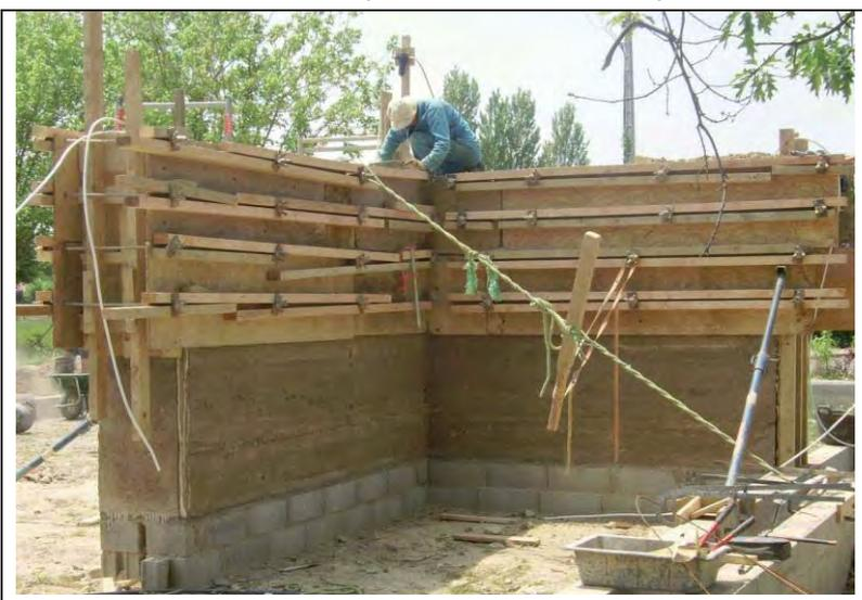
Mur en pisé accumulateur chauffant/ rafraichissant bâti avec la terre des fondations et perclu de tuyau raccordés en hauteur 2 m 85)
