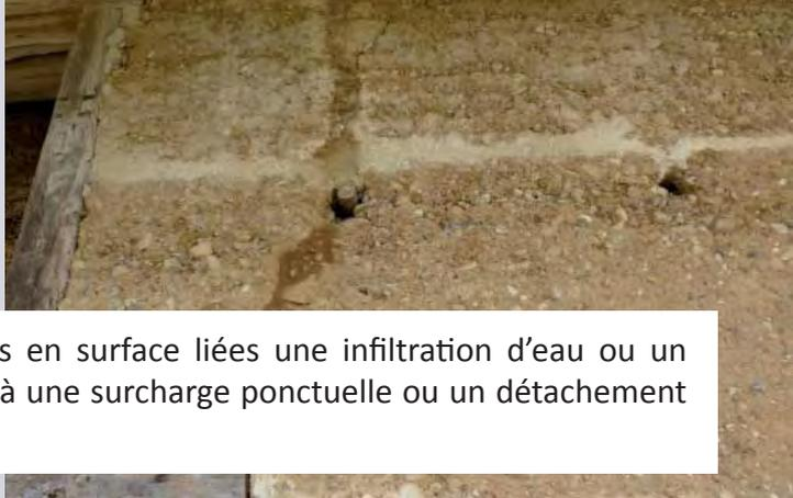
Il existe plusieurs types de fissures : les petites fissures en surface liées à une infiltration d'eau ou un ruissellement prolongé ou des fissures structurelles liées à une surcharge ponctuelle ou un détachement en deux éléments de structure.
