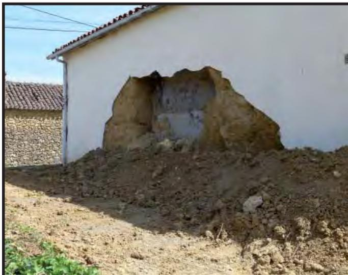
*Effondrement d'un bout de mur enfermé entre un enduit ciment et des blocs de parpaing*
