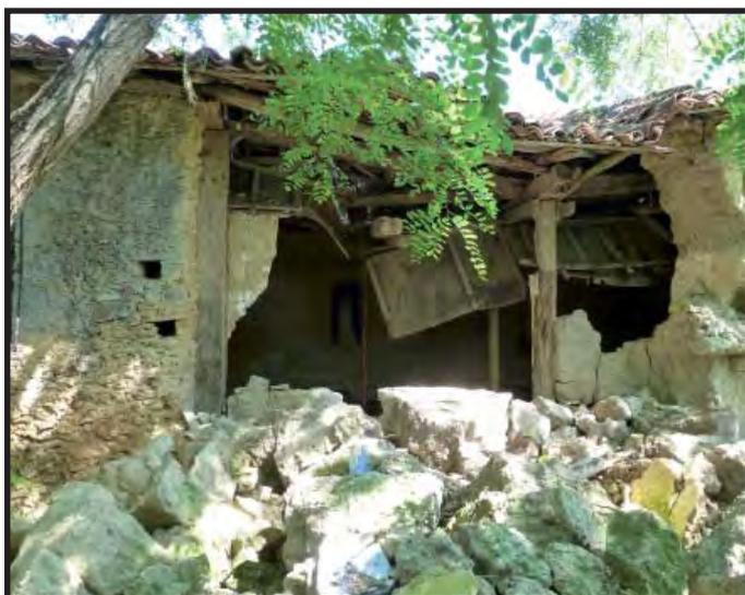
*Effondrement d'un mur à cause d'une toiture abîmée (poussée de la charpente et infiltration d'eau)*
