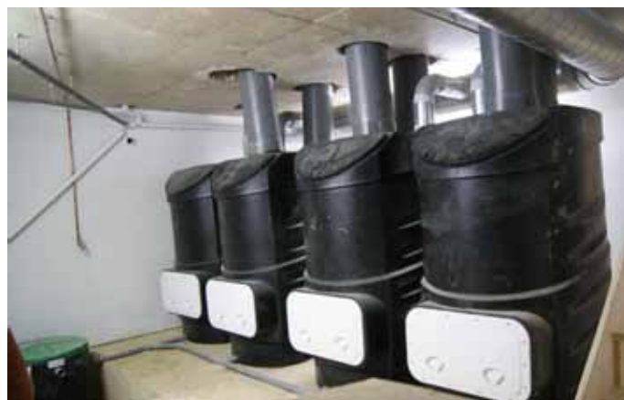
École de Saint-Germé (32) 4 composteurs raccordés à 7 cuvettes
