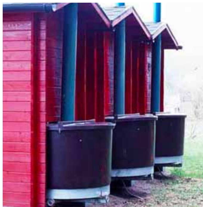
Composteurs extérieurs et ventilation passive
